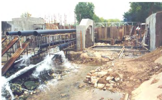
Açude do Arrabalde: rio a escoar apenas nos tubos inferiores, durante a execução da obra
