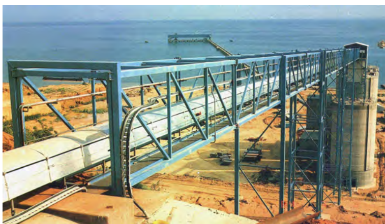
Vista de terra do cais de acostagem Berthing pier viewed from land
