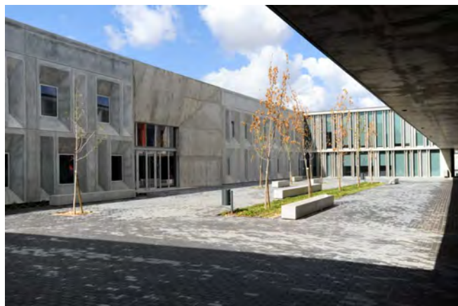
Vista parcial do pátio da Escola
