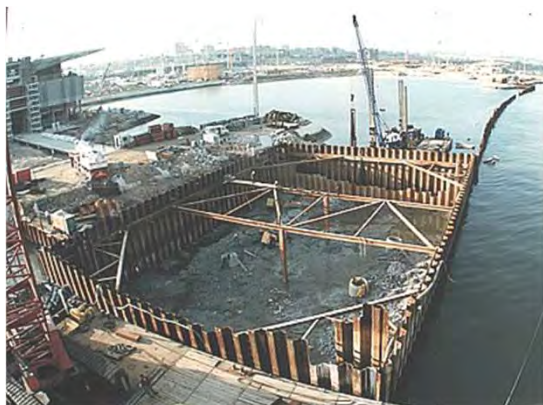
Ensecadeira da eclusa Lock cofferdam
