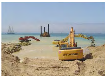
Lançamento da tubagem e vista durante a construção. Pipe launching and Construction in progress.
