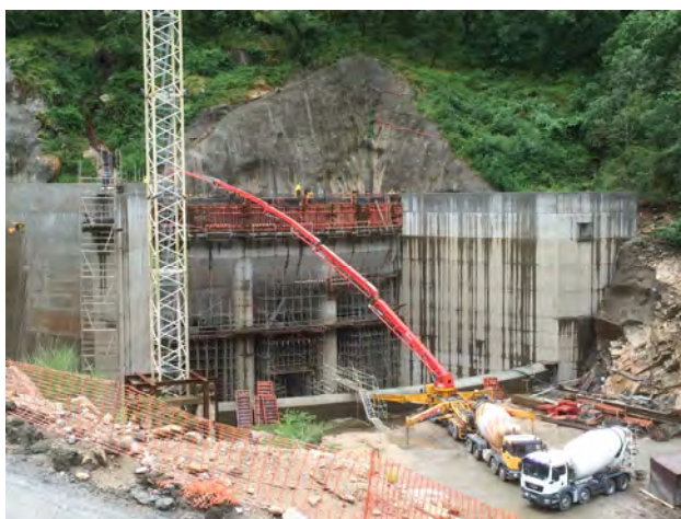
Trabalhos na zona Restituição Albufeira da Caniçada
