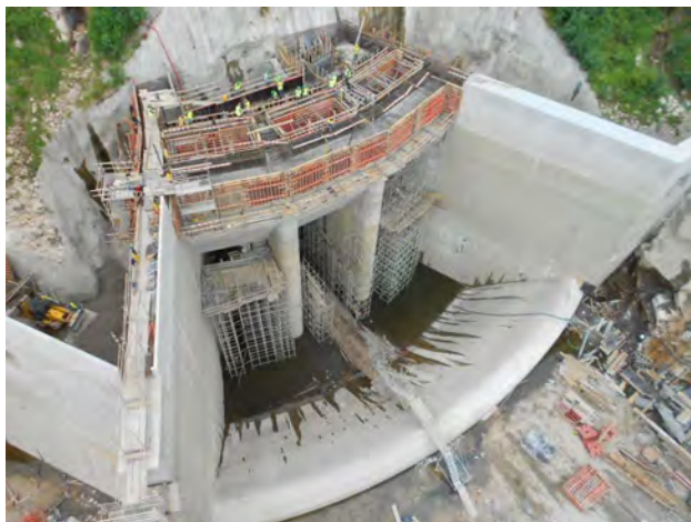
Trabalhos na zona Restituição Albufeira da Caniçada
