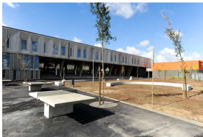
Vista geral dos edifícios da escola
