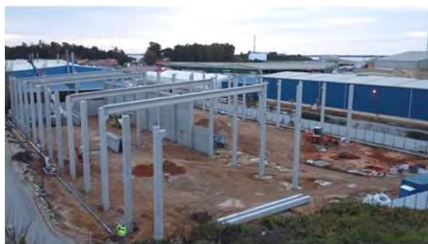
Estruturas de betão
