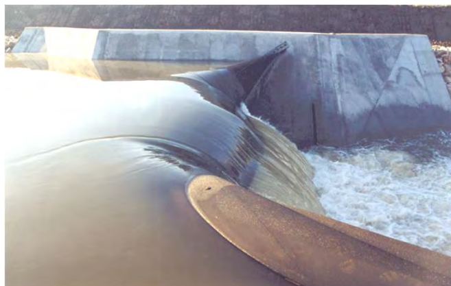
Inflatable Weir at Salgadas em plena carga (pormenor do insuflável)
