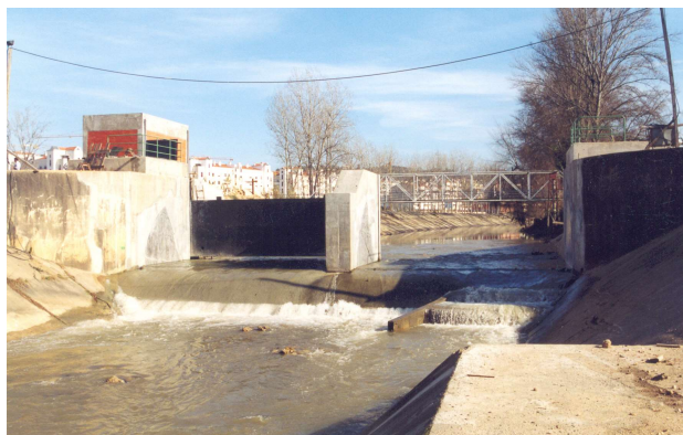
Açude do Arrabalde: vista de jusante dos dois vãos, ensecadeira e casa do comando eléctrico
