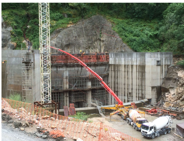
Trabalhos na zona Restituição Albufeira da Caniçada
