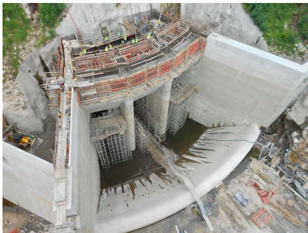
Trabalhos na zona Restituição Albufeira da Caniçada
