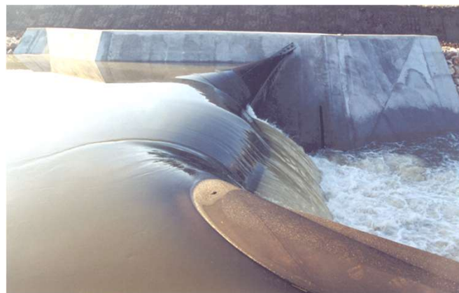
Açude das Salgadas em plena carga (pormenor do insuflável)
