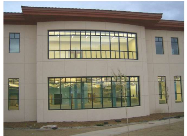
Aspecto do exterior do edifício Outside view of the Fitness Center
