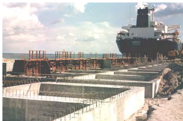
Aspecto dos trabalhos de ampliação do Cais 3 General view of the Pier 3 Extension works
