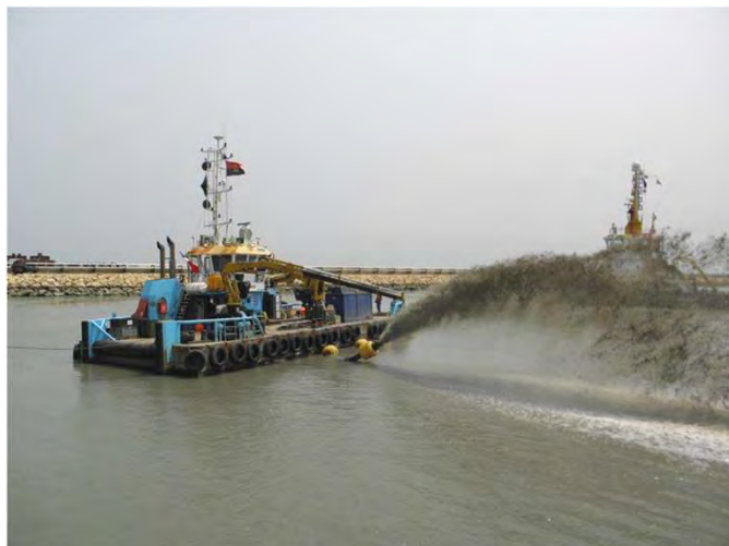
Zona das dragagens durante os trabalhos Zone of dredging during the works
