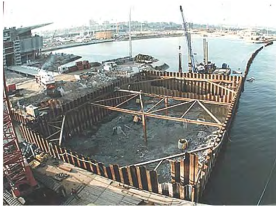
Ensecadeira da eclusa Lock cofferdam
