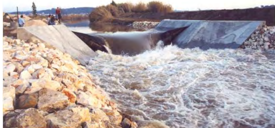
Açude das Salgadas: vista de jusante da margem direita (açude a descarregar com o insuflável a esvaziar)
