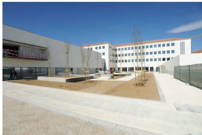
Vista parcial dos edifícios e arranjos exteriores
