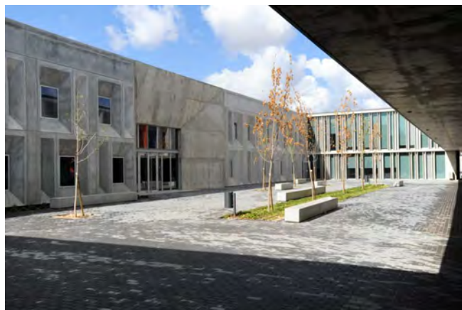
Vista parcial do pátio da Escola
