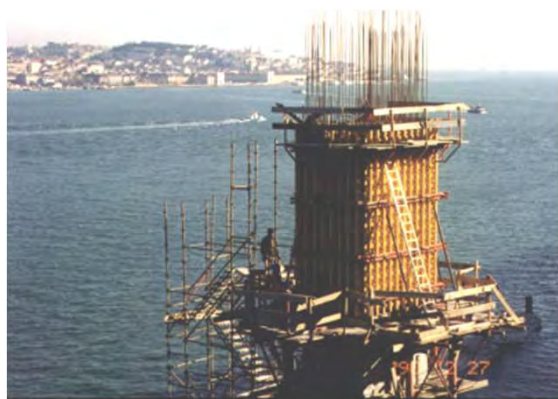
Aspecto da cofragem trepante para a betonagem da torre.
