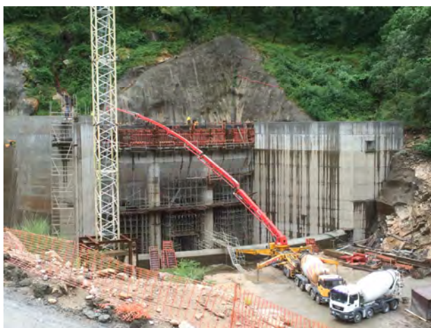
Trabalhos na zona Restituição Albufeira da Caniçada
