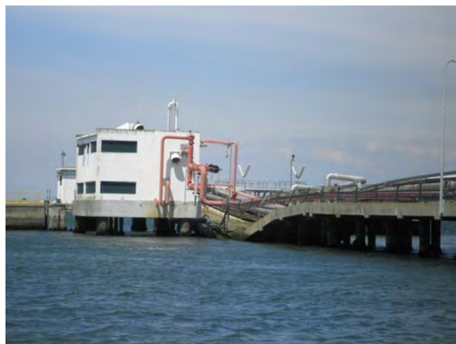
Antes dos trabalhos de reabilitação Before rehabilitation works
