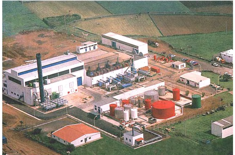
Vista aérea da central termoelétrica de Bejo Jardim À esquerda o edifício da nova ampliação. Em primeiro plano, o novo parque de combustíveis.
