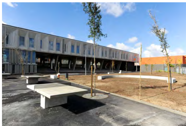
Vista geral dos edifícios da escola
