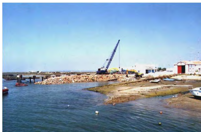
Topo: aspecto, após a conclusão Top: view, after completion
