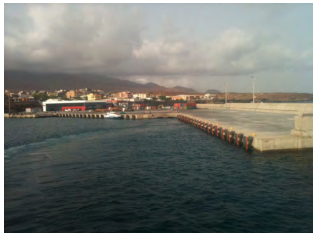
Vista geral da zona portuária intervencionada nesta empreitada General view of the port area after intervention of this work
