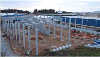
Estruturas de betão
