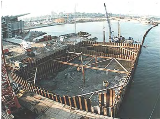
Ensecadeira da eclusa Lock cofferdam
