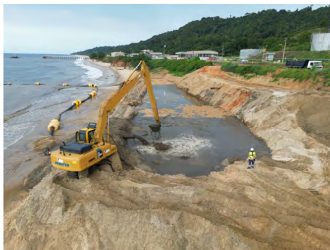
Frente de trabalhos com recurso a maquinaria de movimentação de terras. Extracting sand using earthmoving machinery.
