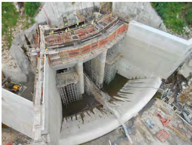
Trabalhos na zona Restituição Albufeira da Caniçada
