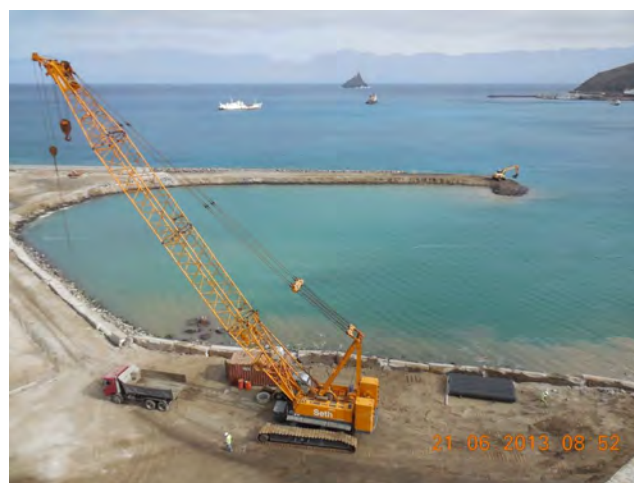
Vista geral da zona portuária intervencionada nesta empreitada General view of the port area after intervention of this work
