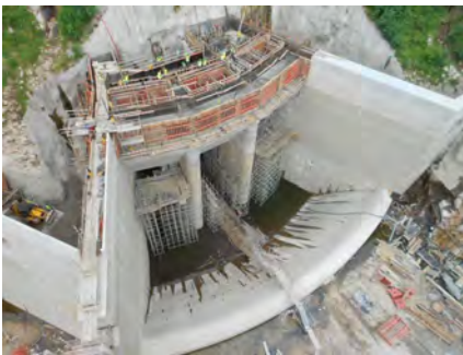
Barragem de Salamonde (trabalhos na zona Restituição Albufeira da Caniçada)
