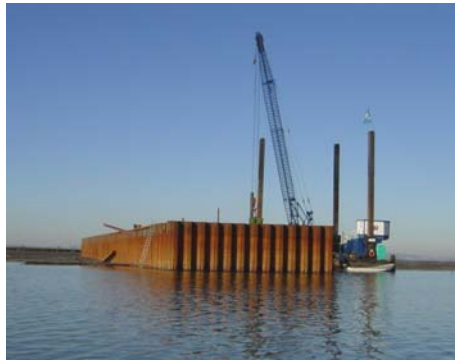
Ensecadeira (estacas-prancha) Trabalhos de Perfuração Horizontal Dirigida para o Gasoduto Sines-Setúbal
