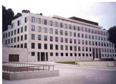
Assembleia da República Edifício de Ampliação Lisboa
