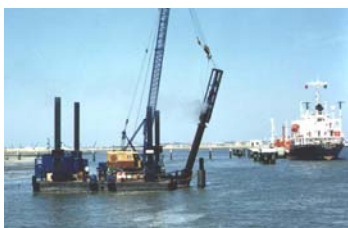
Petrogal - Aveiro Cravação de estacas
