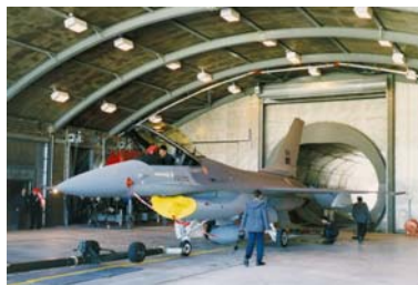
FAP - Base Aérea de Monte Real Edifício de ensaio de motores de avião
