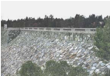
Barragem do Vale do Gaio Construída pela SETH em 1949
