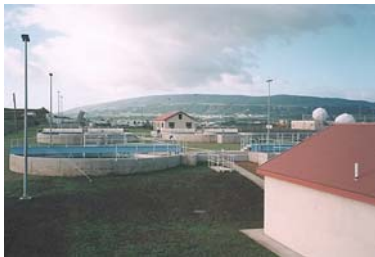
U.S. Navy Base Aérea das Lajes, Açores Estação de Tratamento de Águas Residuais
