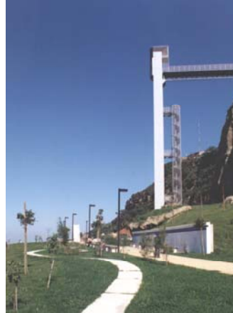
Elevador Panorâmico Boca do Vento - Almada
