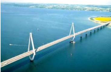
Ponte sobre o Farøbroen Dinamarca
