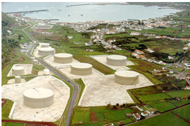
US Navy - Açores Reparação de tanques POL
