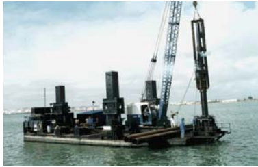
Plataforma auto-elevatória “Valeira” Cravação de estacas
