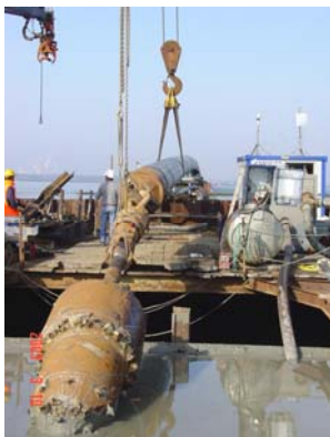
Gasoduto Sines-Setúbal Perfuração HDD (Rio Sado)
