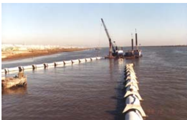
Obras marítimas: Construção da tomada de água Valorsul
