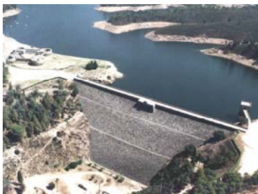
Barragem do Pego do Altar Construída pela SETH em 1949
