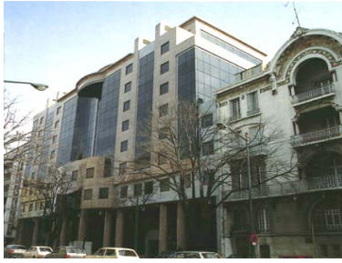
Edifício “Dinamarca” R. Alexandre Herculano (Lisboa) 26 000 m2
