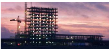
Lindberg Installation a/s Desde linhas de alta tensão até redes LAN
