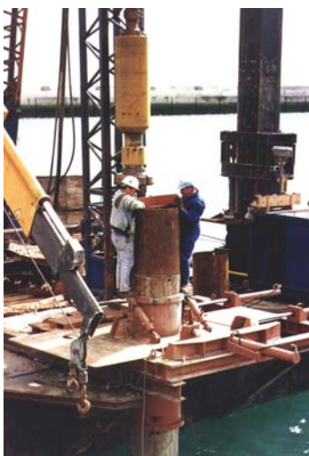
Cravação de estacas
