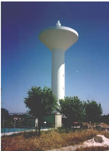
Depósito de água elevado Alpiarça
