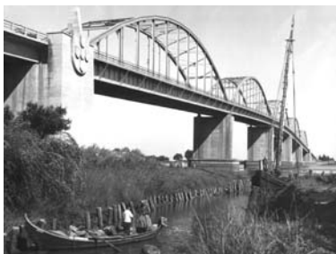
Ponte Marechal Carmona Construída pela SETH em 1951
