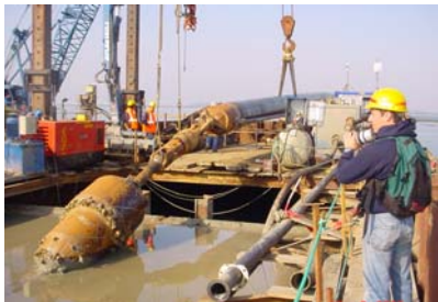
Gasoduto Sines-Setúbal Perfuração Horizontal Dirigida na Travessia do Estuário do Sado Operação de “Pull-Back”
