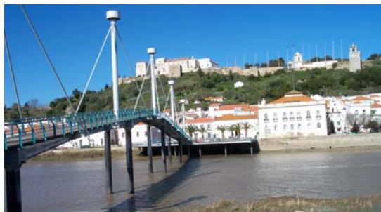
Ponte Pedonal, Alcácer do Sal Pilares suportados por estacas tubulares cravadas (Ø 708 e 508 mm)
