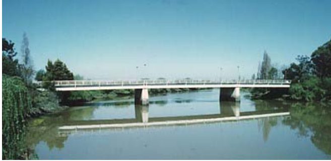
Ponte da "Vala Nova", Benavente. A primeira ponte construída em Portugal com betão pré-esforçado. Construída pela SETH em 1954
