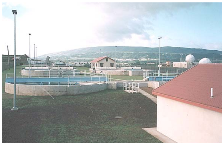
Vista geral da ETAR. Em segundo plano, os tanques de clarificação General view of the WWTP. Background: the clarifier tanks
