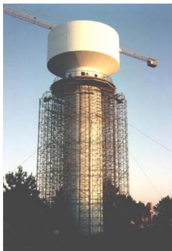
Aspecto das torres de escoramento.
