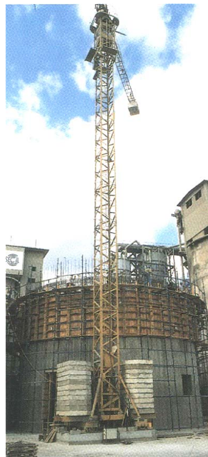
Aspecto da armadura do cone de descarga. Densidade de aço: 190 kg/m 3
