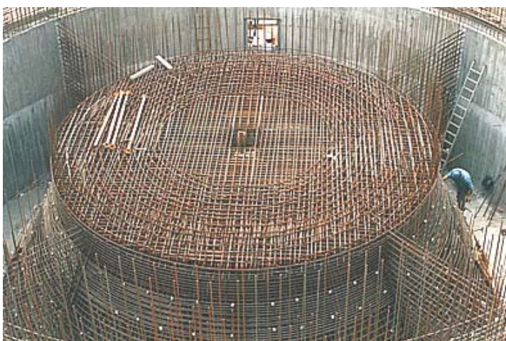
Aspecto da armadura do cone de descarga. Densidade de aço: 190 kg/m 3
