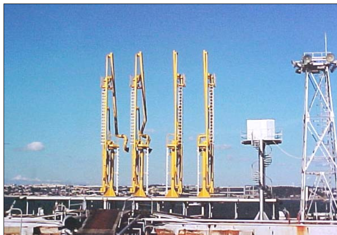
Em cima: Vista dos braços de carga, após a montagem Top: The loading arms after assembly and erection.
